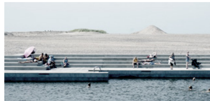
betontrappe langs kajkant skaber adgang til vandet
